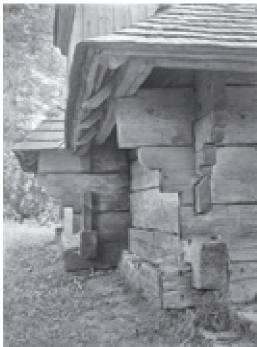
8. Сушиця Велика (п. Самбір), піддашшя ц. св. Николи 1751 р. 8. Sušycja Welyka (B. Sambor), die Konstruktion des Pultdaches der Kirche v. 1751 J.
