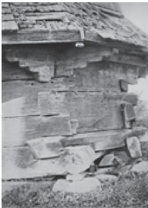
3. Малнів (п. Мостиська), ц. [Св. Параскеви] поч. XVII в., стіна пресвітерії. 3. Malniv (B. Mostyska), die Kirche v. XVII Jhrht., das Wandgebälk des Presbyteriums.
